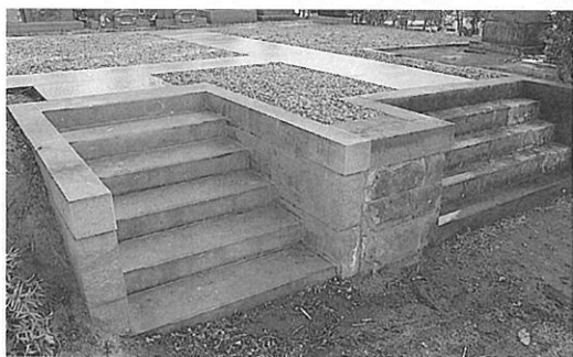
通用口としての階段を旧階段の横に新設
